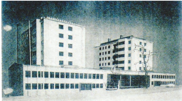
Arkkitehtien näkemys Hämeenlinnan Postikonttorin uudesta liiketilasta, matala osa. Se ja siihen liittyvät kaksi tornitaloa valmistuivat vuonna 1953.
