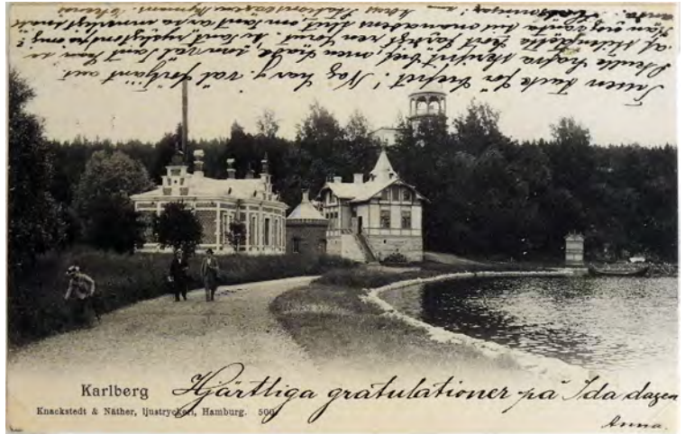
Sauna ja pesuhuone sekä pumppuhuone, vain pumppuhuone on jäljellä.
