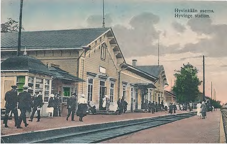
Hyvinkään rautatieasema laajenuksessa lisättiin aseman molempiin päihin lisäosat.
